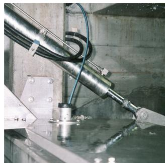
ARA Kolben, Messsonde
